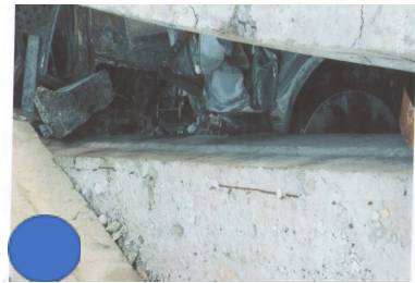
Рисунок 2. Пошкодження КТЗ внаслідок ракетного обстрілу
